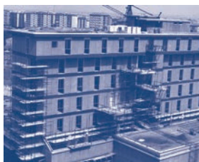
Il cantiere, primi anni '70
